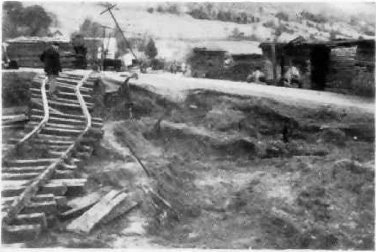
Zerstörung des Bahndamms und der Schiene in Riñihue.
